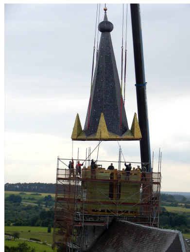
Les ouvriers guident la remise en place correcte du clocher
