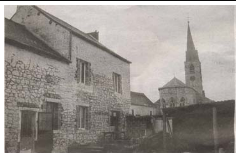
On doit encore placer des Velux en toiture.
